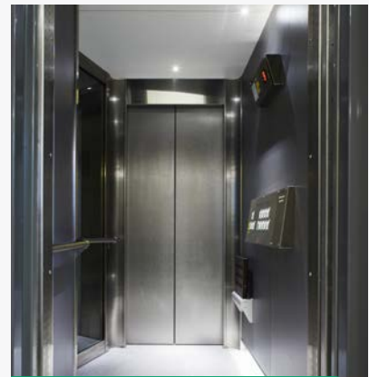
Specialbyggd korg i rostfritt stål.
