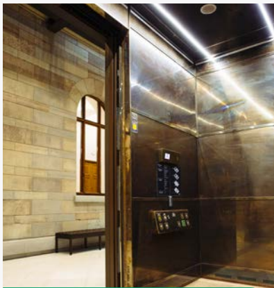
Specialbyggd hisskorg med oxiderad plåt och mässing.
